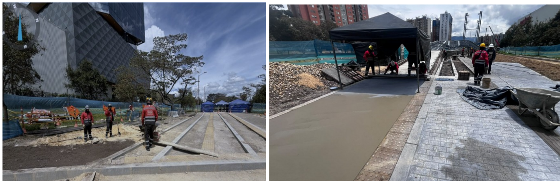
Fotografía N°2: Actividades instalación de bordillo A-80, conformación de áreas de espacio público y estampado de concreto.
