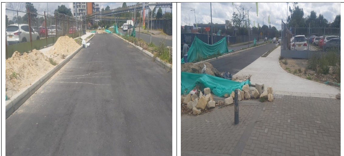
Figura 3 y 4. Imágenes estado actual vía Cra 82 (Cra. 79 en plano), de la Urbanización SAN CAYETANO (Predio AC26 78A-92).
