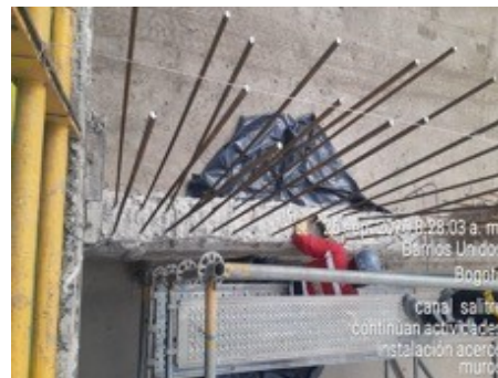
Ilustración Perforación en pantallas existentes C, D y E
