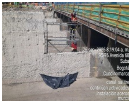
Ilustración Perforación en pantallas existentes C, D y E
