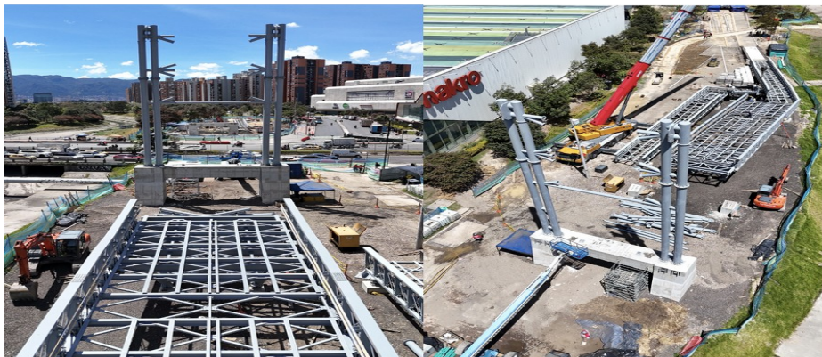
Fotografía N°1: Instalación de estructura del mástil principal sobre las columnas del costado occidental. (28/09/2026)
