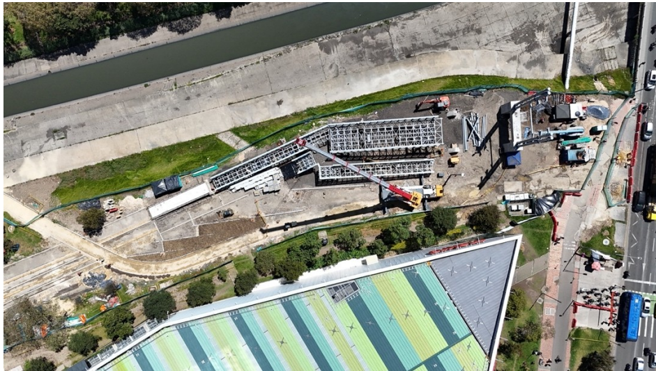
Fotografía N°6: Estado actual costado occidental (30/09/2026)
