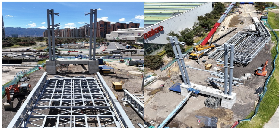
Fotografía N°1: Instalación de estructura del mástil principal sobre las columnas del costado occidental. (28/09/2026)
