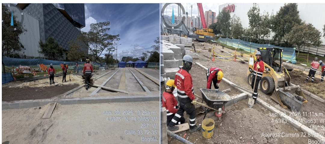
Fotografía N°3: Actividades instalación de bordillo A-80 y conformación de áreas de espacio público
