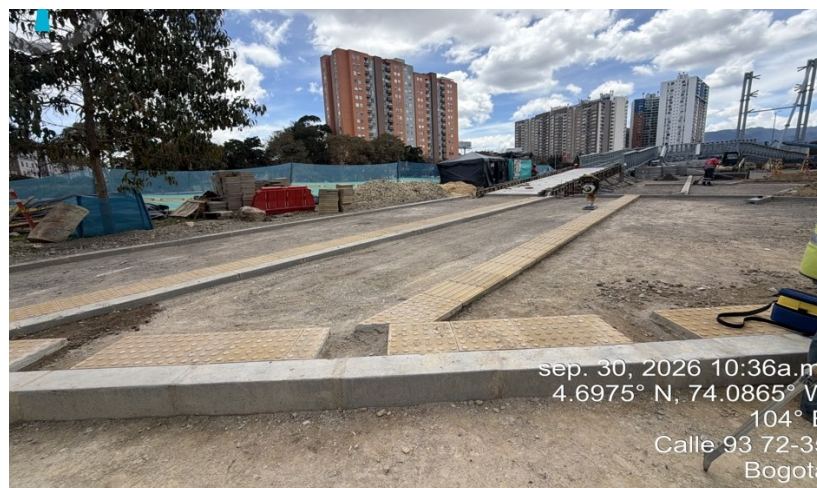
Fotografía N°5: Instalación de losetas prefabricadas de alerta en el costado occidental
