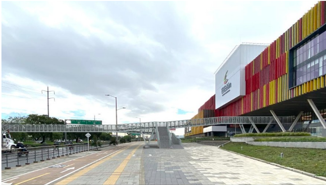
Imagen 1 – Panorámica del Puente. Fuente Construcciones Planificadas
