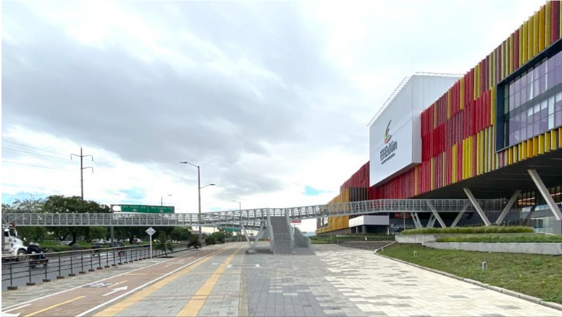
Imagen 1 – Panorámica del Puente. Fuente Construcciones Planificadas
