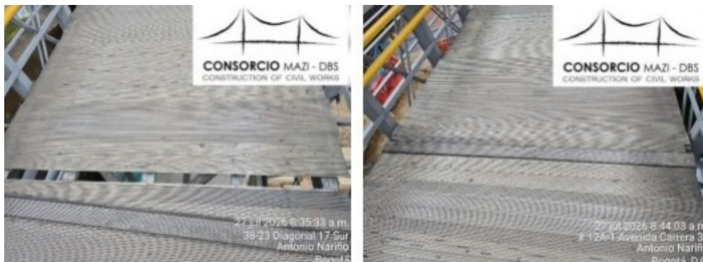
Fotografía No.7 y No.8: Antes y después de la intervención
