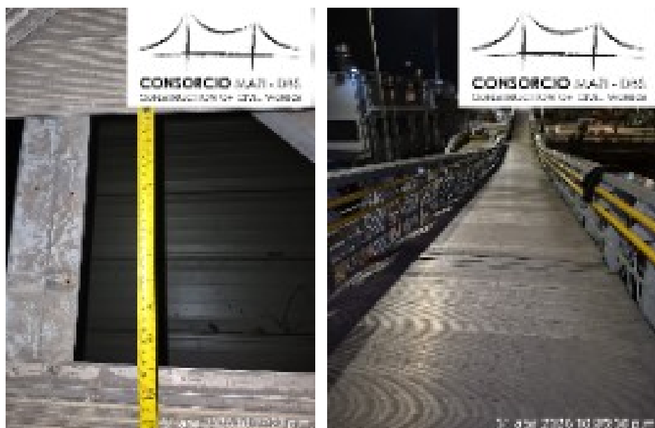
Fotografía No.9 y No.10: Antes y después de la intervención
