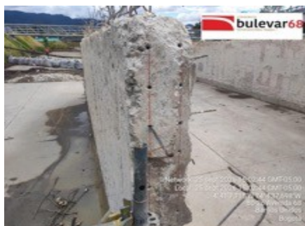
Ilustración Perforación en pantallas existentes C, D y E
