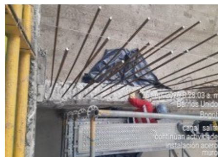
Ilustración Perforación en pantallas existentes C, D y E
