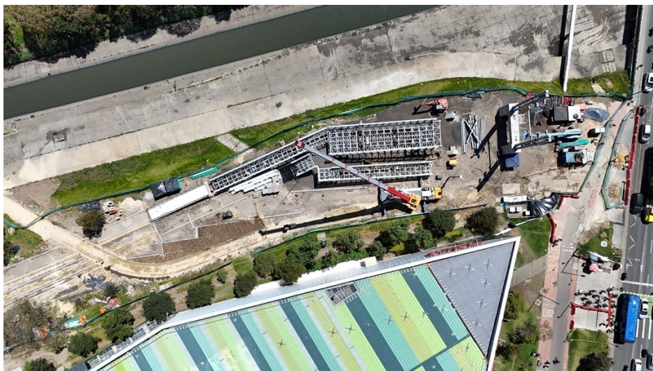
Fotografía N°6: Estado actual costado occidental (30/09/2026)
