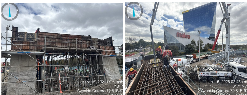
Fotografía N°1: Encofrado y vaciado de viga riostra entre Columnas de apoyo principal de pasarela central en el costado occidental.
