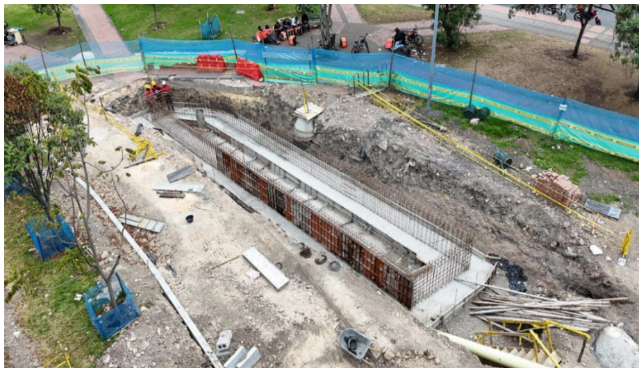
Fotografía N°4: Construcción de zonas de bioretención que forman parte de los Sistemas Urbanos de Drenaje Sostenible (SUDS).
