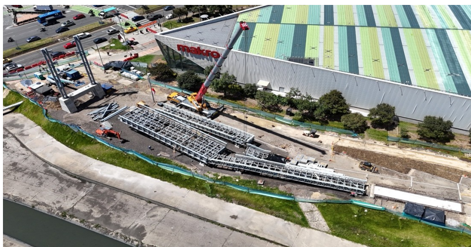
Fotografía N°7: Estructura Metálica del módulo principal en proceso de montaje en el costado occidental (28/09/2026)
