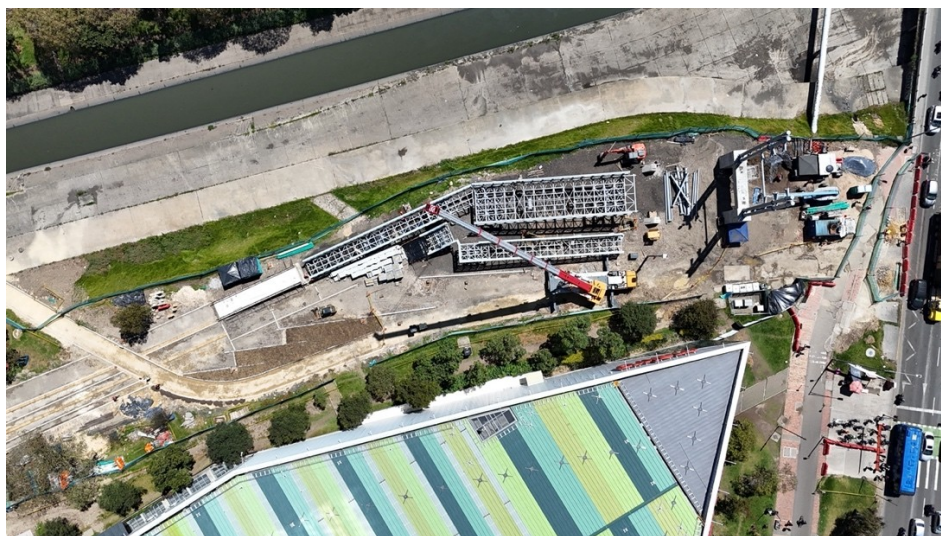
Fotografía N°6: Estado actual costado occidental (30/09/2026)
