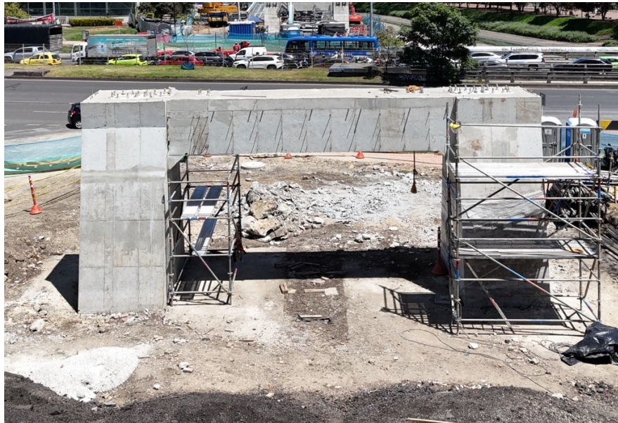
Fotografía N°2 – Desencofrado y apuntalamiento de las Columnas de apoyo principal de pasarela central en el costado oriental. (28/09/2026)
