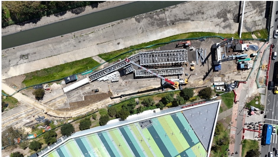
Fotografía N°6: Estado actual costado occidental (30/09/2026)
