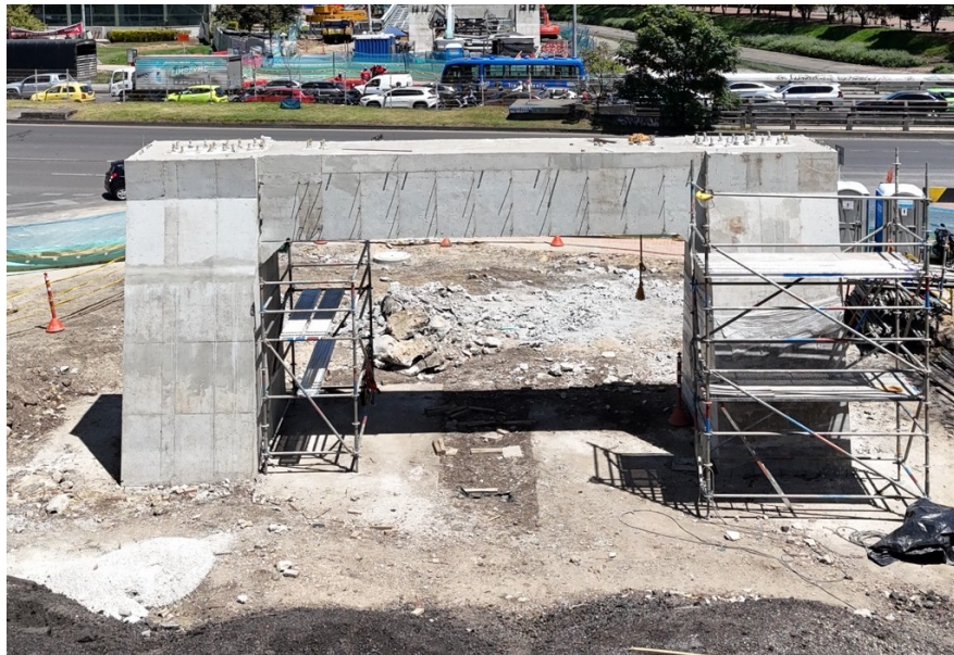
Fotografía N°2 – Desencofrado y apuntalamiento de las Columnas de apoyo principal de pasarela central en el costado oriental. (28/09/2026)
