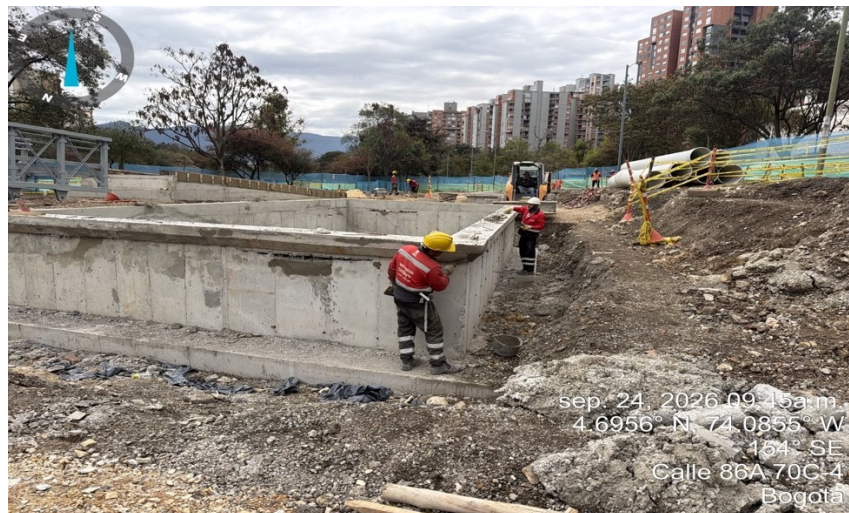
Fotografía N°4: Construcción de zonas de bioretención que forman parte de los Sistemas Urbanos de Drenaje Sostenible (SUDS).
