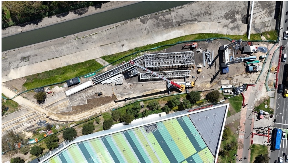
Fotografía N°6: Estado actual costado occidental (30/09/2026)
