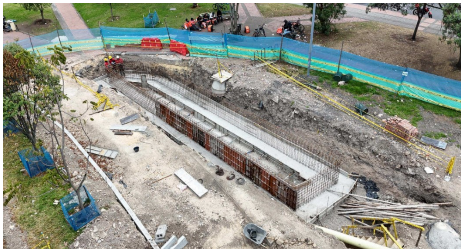
Fotografía N°4: Construcción de zonas de bioretención que forman parte de los Sistemas Urbanos de Drenaje Sostenible (SUDS).
