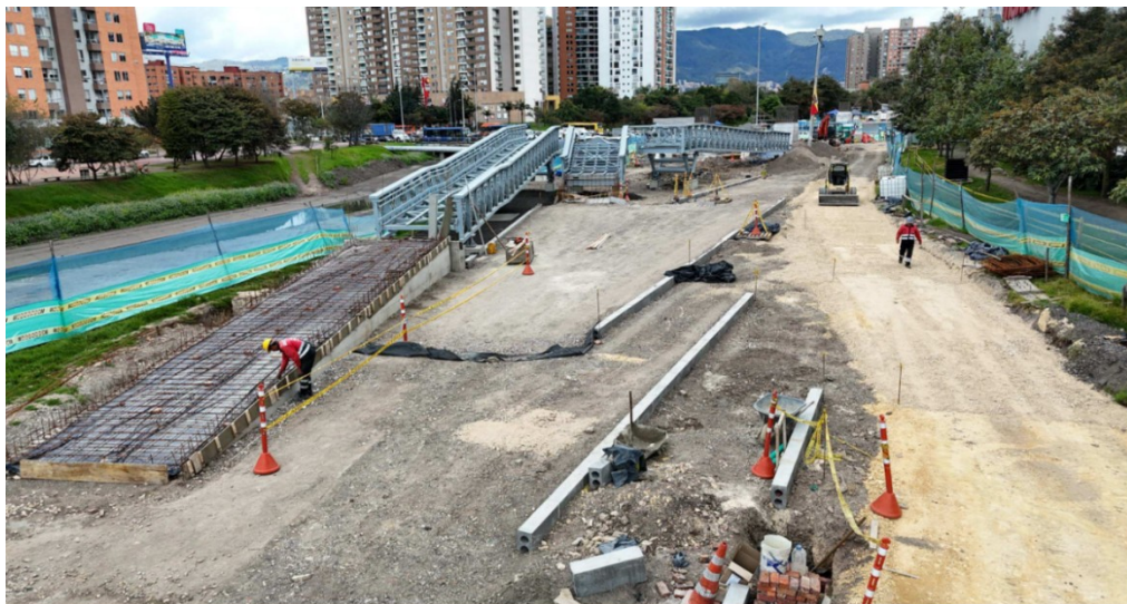
Fotografía N°6: Estado actual costado occidental
