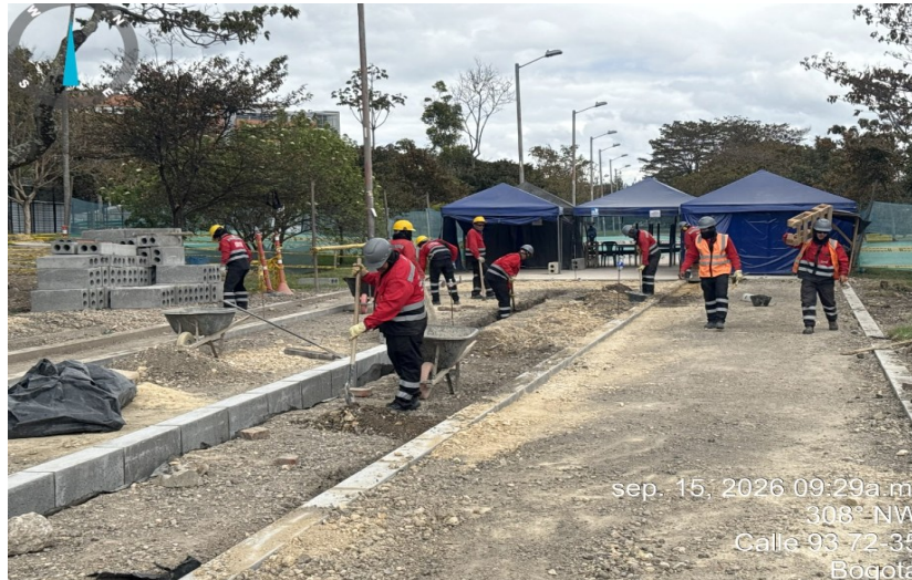
Fotografía N°3: Actividades instalación de bordillo A-80 y conformación de material granular para espacio público
