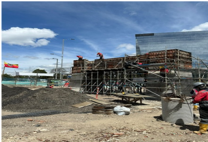
Fotografía N°2 – Instalación de formaleta, posterior al armado de parrillas de acero para viga riostra entre Columnas de apoyo principal de pasarela central en el costado oriental
