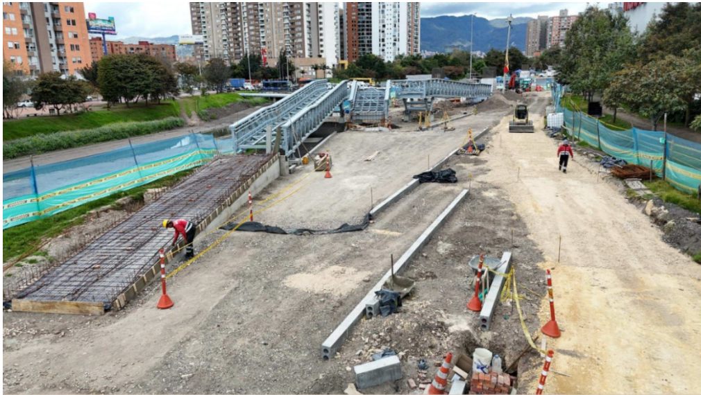
Fotografía N°6: Estado actual costado occidental
