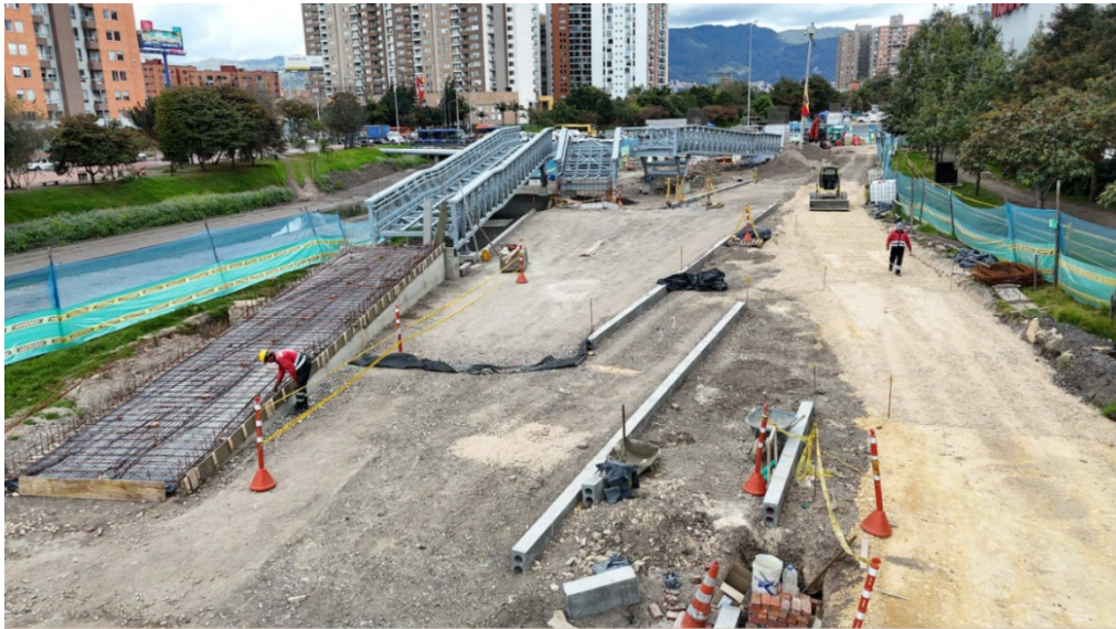
Fotografía N°6: Estado actual costado occidental
