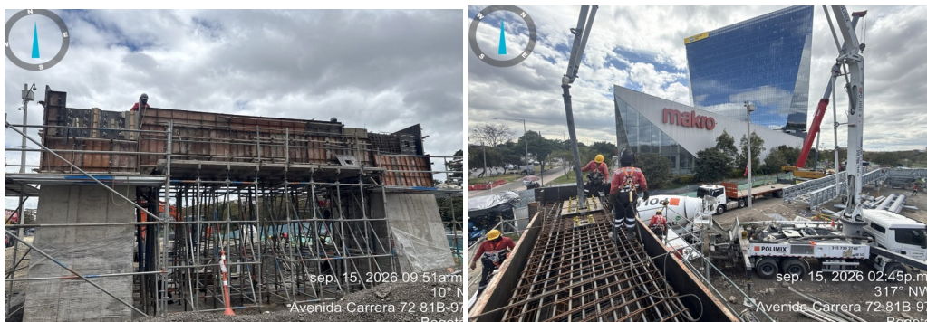
Fotografía N°1: Encofrado y vaciado de viga riostra entre Columnas de apoyo principal de pasarela central en el costado occidental.
