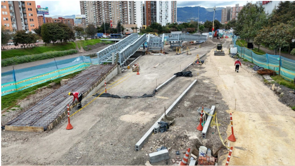
Fotografía N°6: Estado actual costado occidental
