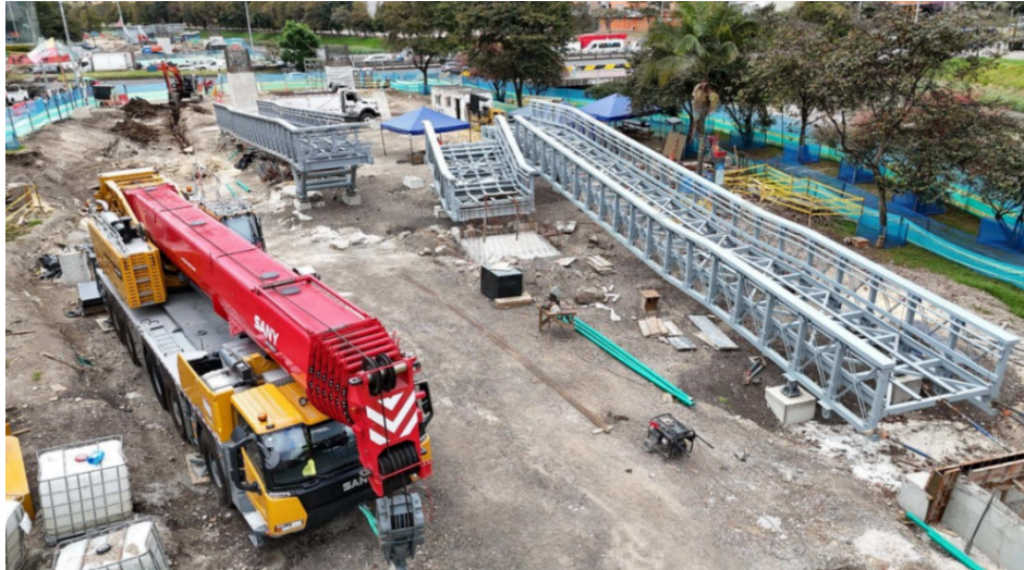
FUENTE: INTERVENTORÍA CAL Y MAYOR SAS
