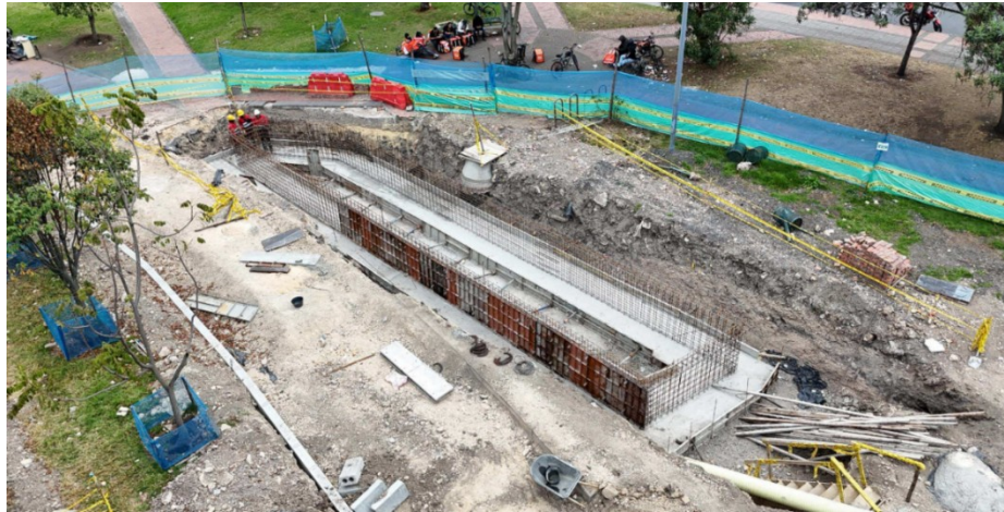
Fotografía N°4: Construcción de zonas de bioretención que forman parte de los Sistemas Urbanos de Drenaje Sostenible (SUDS).
