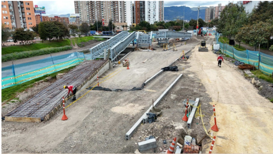
Fotografía N°6: Estado actual costado occidental
