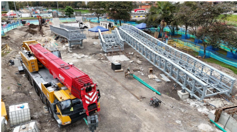
Fotografía N°7 Estado actual costado oriental
