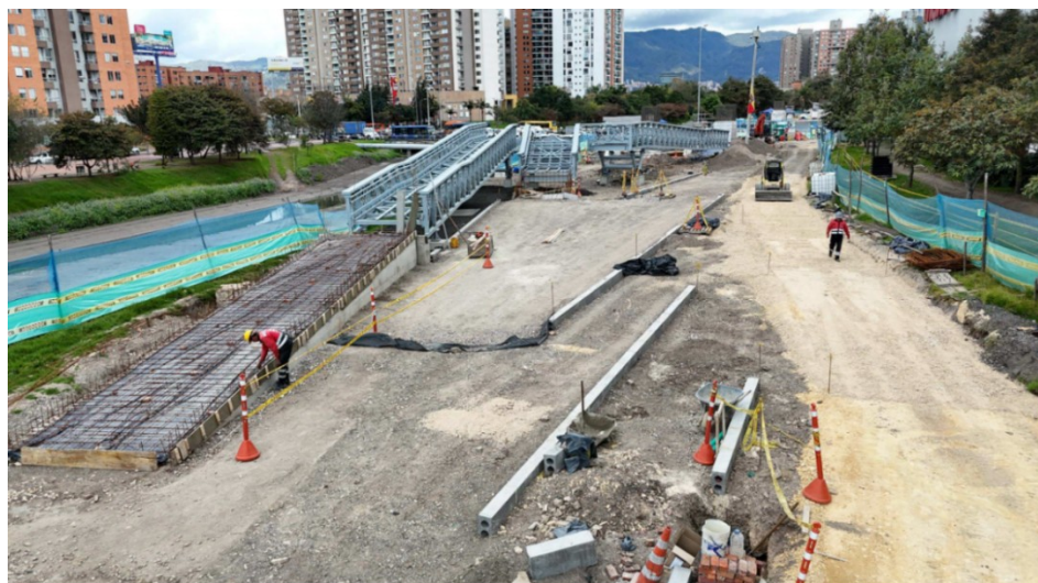
Fotografía N°6: Estado actual costado occidental
