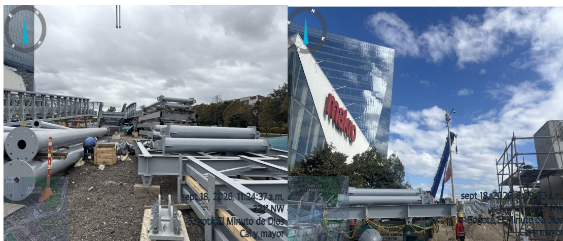
Fotografía N°5: Llegada de Estructura Metálica al frente de obra occidental
