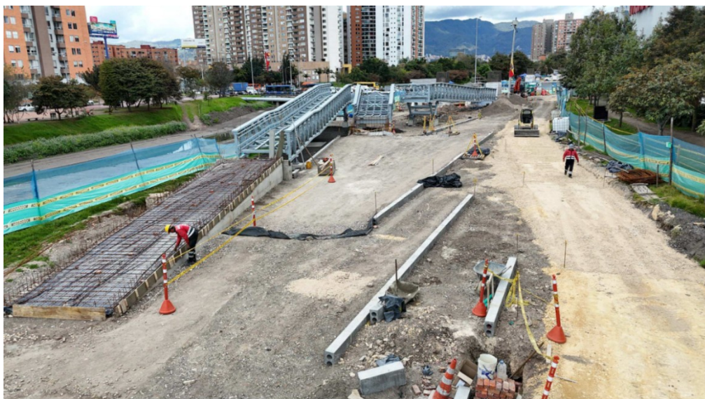
Fotografía N°6: Estado actual costado occidental
