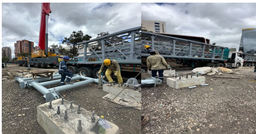
Fotografía N°7: Estructura Metálica en proceso de preensamble y montaje en costado oriental
