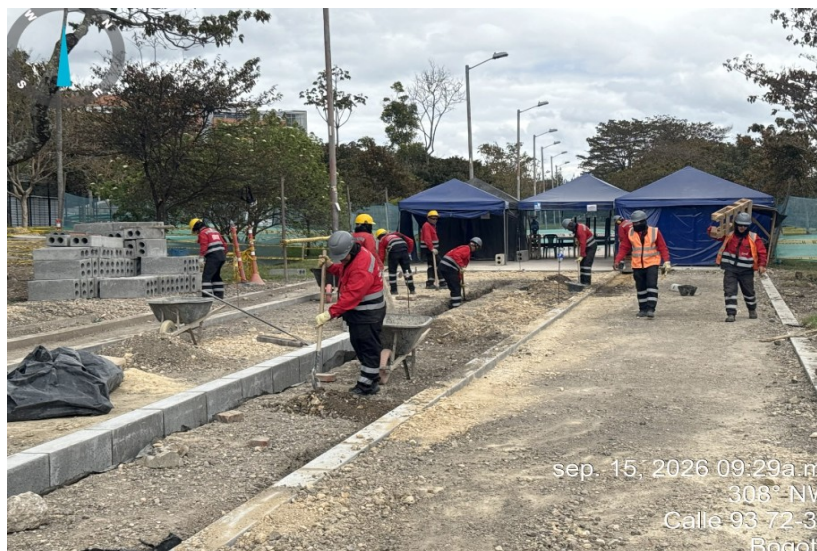
Fotografía N°3: Actividades instalación de bordillo A-80 y conformación de material granular para espacio público
