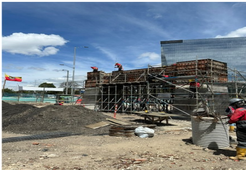
Fotografía N°2 – Instalación de formaleta, posterior al armado de parrillas de acero para viga riostra entre Columnas de apoyo principal de pasarela central en el costado oriental
