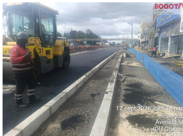
Imagen construcción andén y Ciclorruta costado oriental
