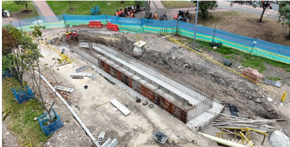
Fotografía N°4: Construcción de zonas de bioretención que forman parte de los Sistemas Urbanos de Drenaje Sostenible (SUDS).
