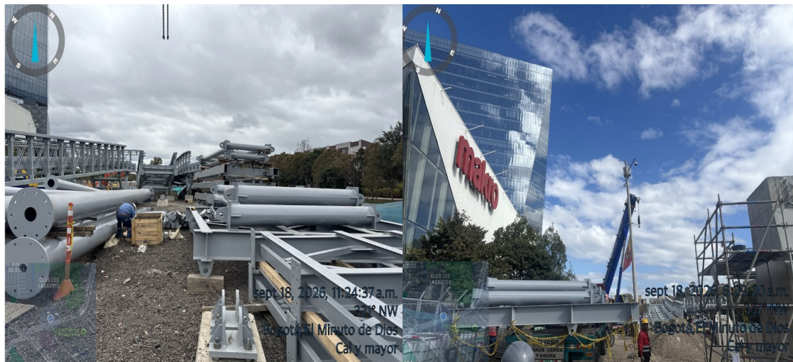
Fotografía N°5: Llegada de Estructura Metálica al frente de obra occidental
