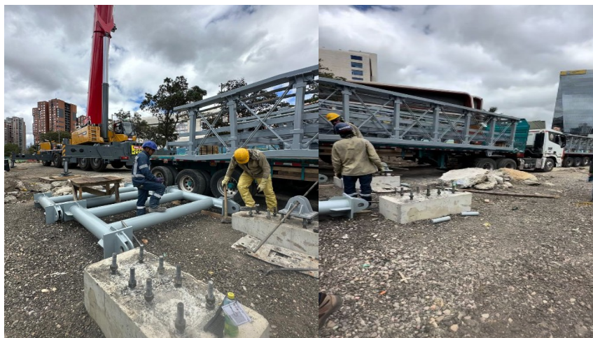
Fotografía N°7: Estructura Metálica en proceso de preensamble y montaje en costado oriental
