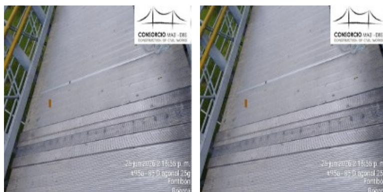
Fotografía No.3 y No.4: Antes y después de la intervención
