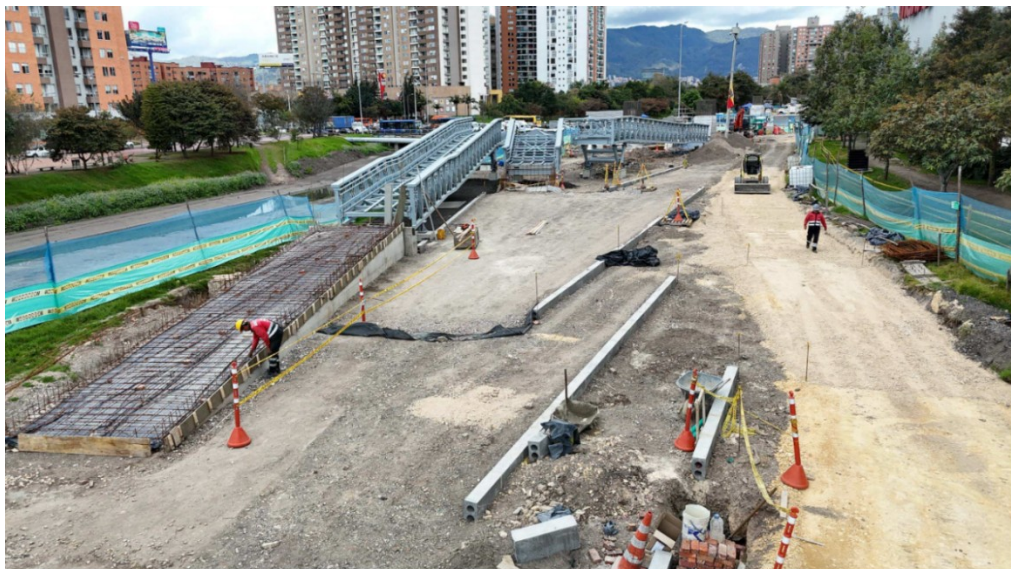
Fotografía N°6: Estado actual costado occidental
