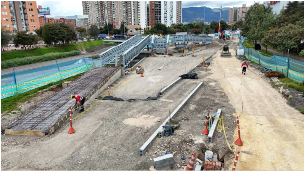
Fotografía N°6: Estado actual costado occidental
