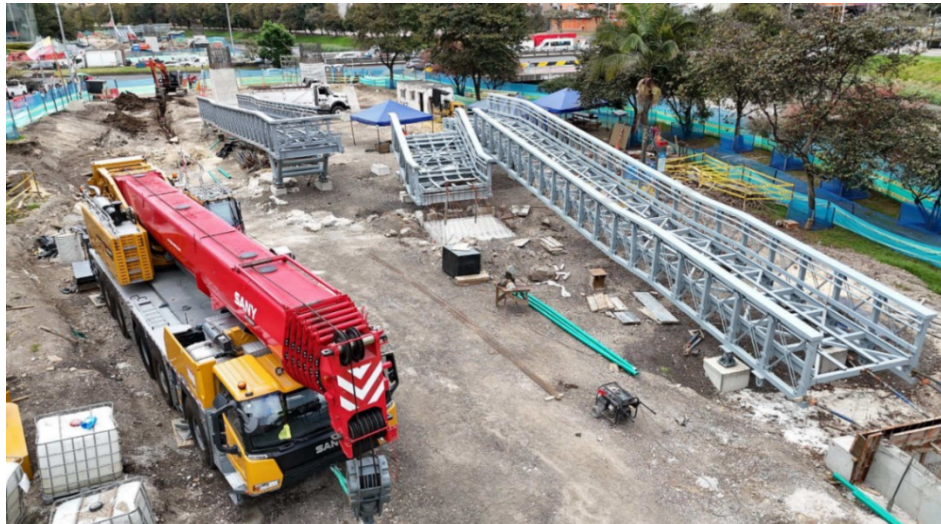
FUENTE: INTERVENTORÍA CAL Y MAYOR SAS
