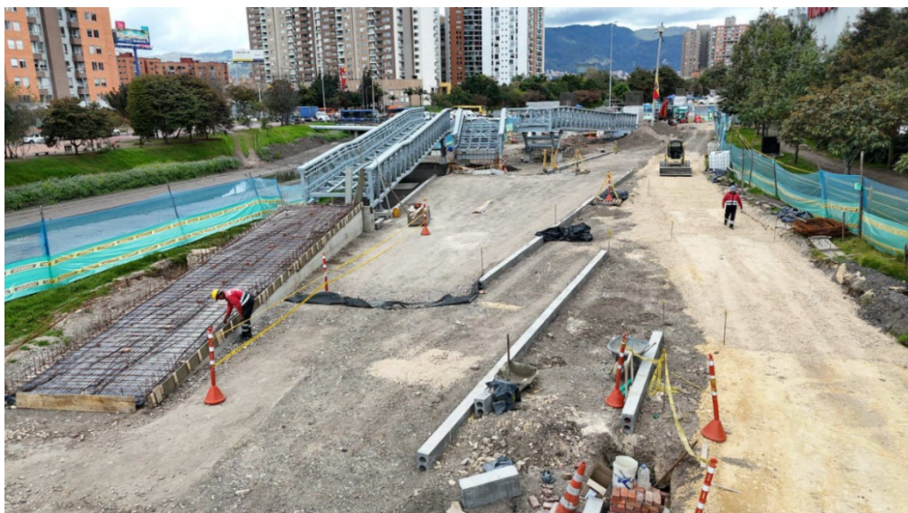
Fotografía N°6: Estado actual costado occidental
