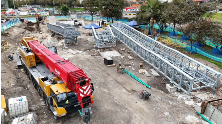
Fotografía N°8 Estado actual costado oriental
