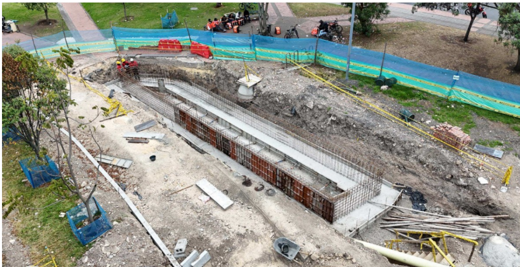
Fotografía N°4: Construcción de zonas de biorretención que forman parte de los Sistemas Urbanos de Drenaje Sostenible (SUDS).
