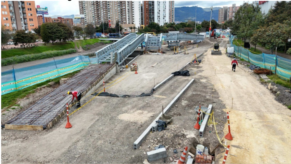
Fotografía N°6: Estado actual costado occidental
