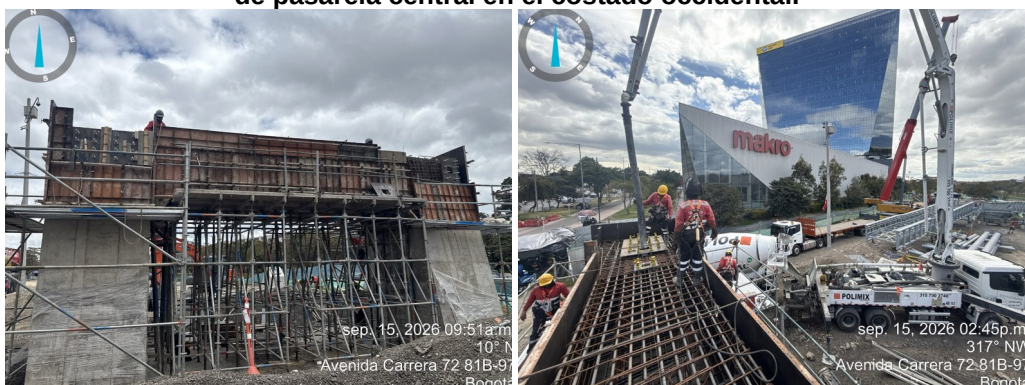
Fotografía N°1: Enconfrado y vaciado de viga riostra entre Columnas de apoyo principal de pasarela central en el costado occidental.
