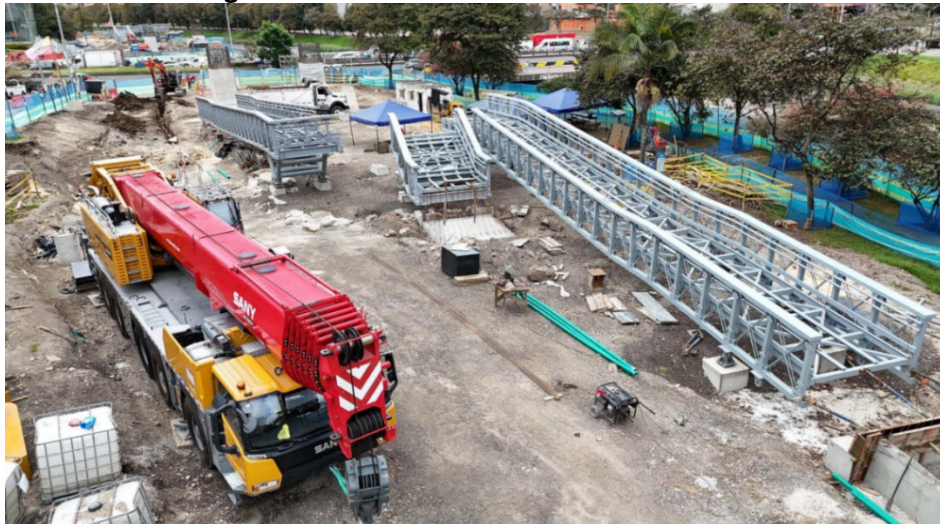
Fotografía N°8 Estado actual costado oriental
