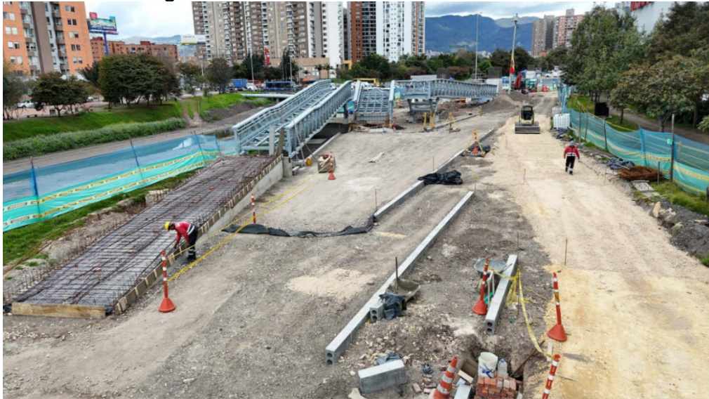
Fotografía N°6: Estado actual costado occidental
