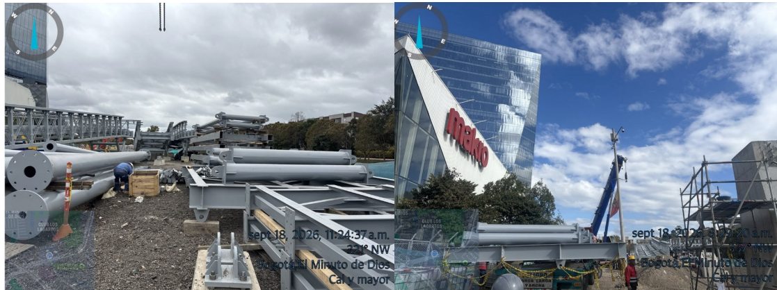
Fotografía N°5: Llegada de Estructura Metálica al frente de obra occidental
