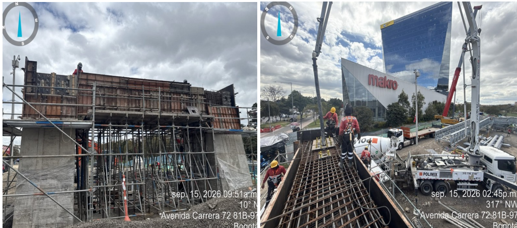
Fotografía N°1: Enconfrado y vaciado de viga riostra entre Columnas de apoyo principal de pasarela central en el costado occidental.
