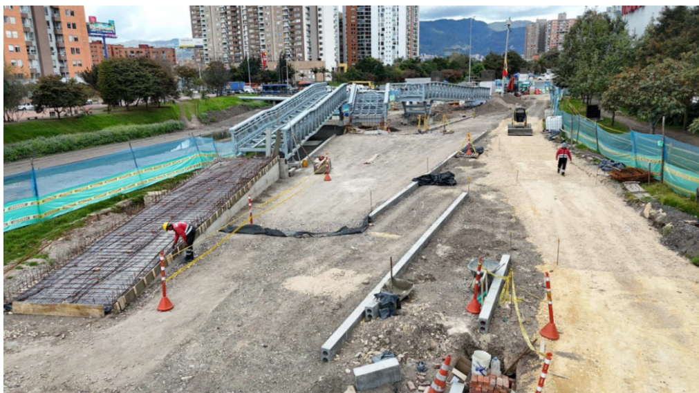
Fotografía N°6: Estado actual costado occidental
