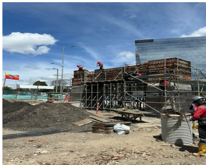
Fotografía N°2 – Instalación de formaleta, posterior al armado de parrillas de acero para viga riostra entre Columnas de apoyo principal de pasarela central en el costado oriental
