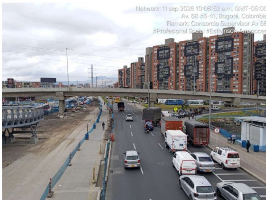
Fotografía del Consorcio Supervisor AV68. Carrera 68 con calle 3 sentido norte - sur zona baja del puente vehicular de la calle 3 – Terminado
