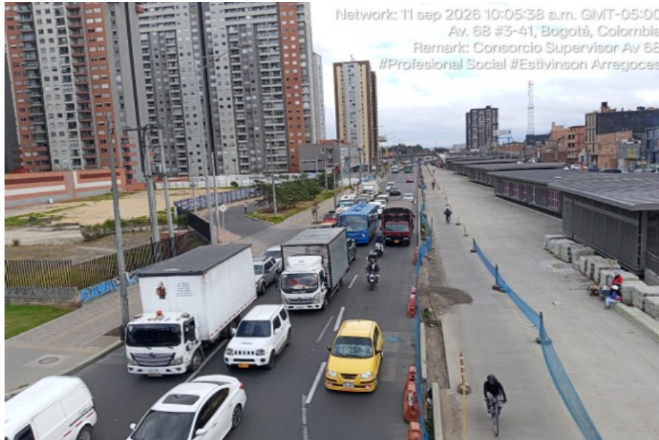
Fotografía del Consorcio Supervisor AV68. Carrera 68 con calle 3 sentido norte - sur zona baja del puente vehicular de la calle 3 – Terminado
