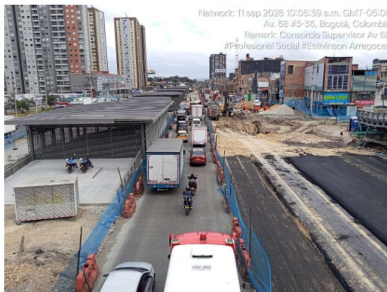
Fotografía del Consorcio Supervisor AV68. Carrera 68 con calle 3 sentido sur – norte, zona baja del puente vehicular de la calle 3 – en obra
