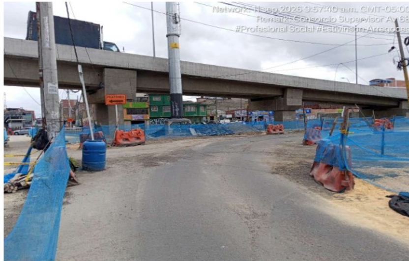
Fotografía del Consorcio Supervisor AV68. Conectante de la calle 3 con carrera 68 sentido sur - occidente: En construcción
