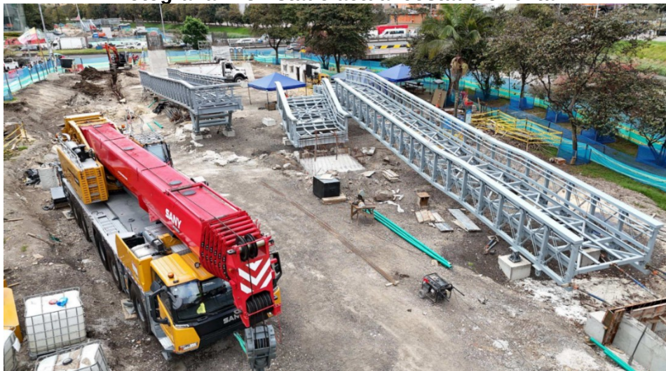
Fotografía N°8 Estado actual costado oriental
