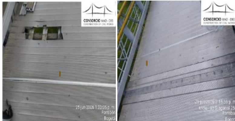
Fotografía No.1 y No.2: Antes y después de la intervención
