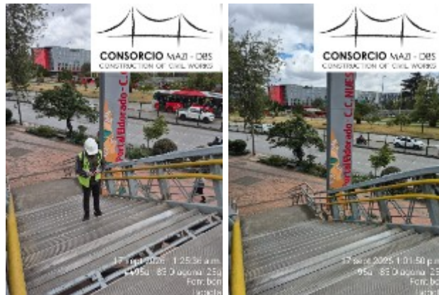
Fotografía No.11 y No.12: Antes y después de la intervención
