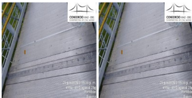
Fotografía No.3 y No.4: Antes y después de la intervención
