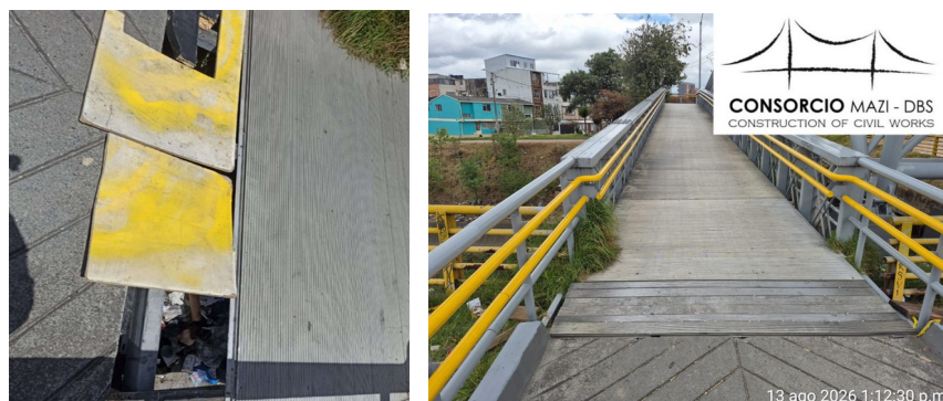
Fotografía No.3 y No.4: Antes y después de la intervención
