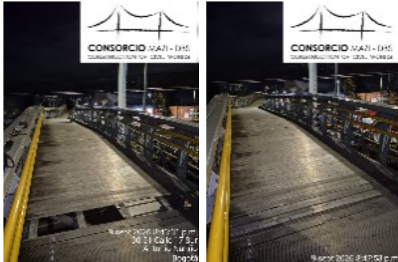
Fotografía No.13 y No.14: Antes y después de la intervención
