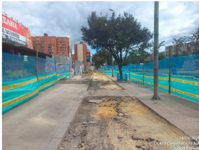
Fotografía 1. Localización del CIV 19001884 – Av. Villavicencio (AC 68 Sur Diagonal 67 a Sur), sector objeto de intervención del Contrato de Obra No. IDU-1557-2025.
