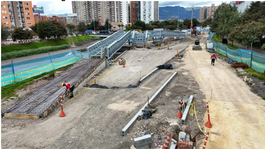
Fotografía N°6: Estado actual costado occidental
