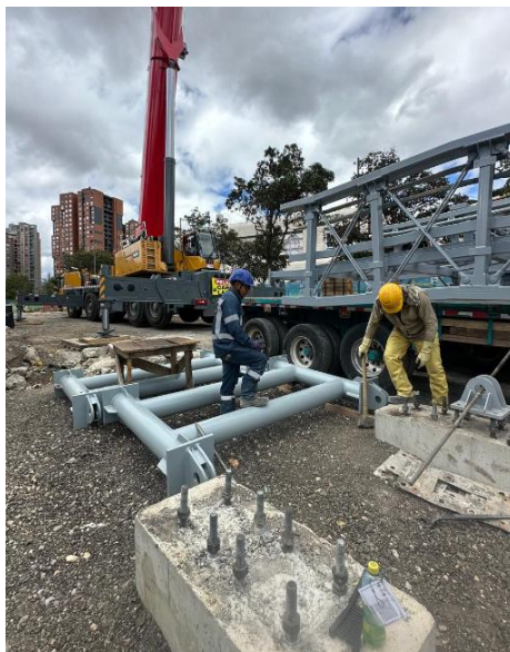
Fotografía N°7: Estructura Metálica en proceso de preensamble y montaje en costado oriental
