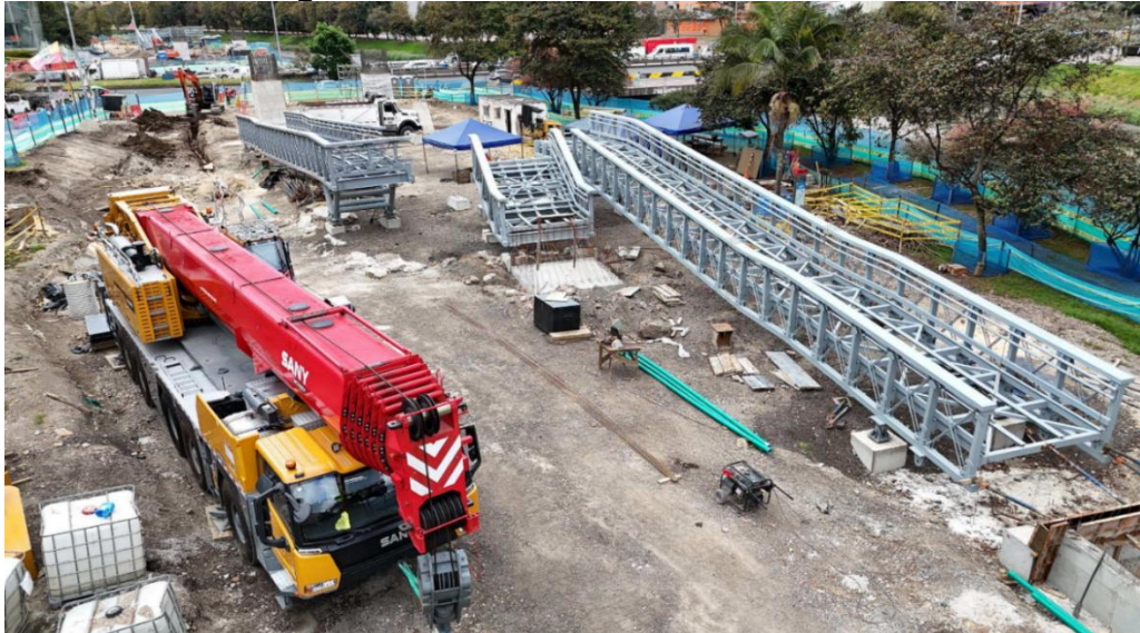
Fotografía N°8 Estado actual costado oriental
