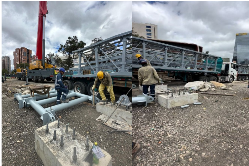
Fotografía N°7: Estructura Metálica en proceso de preensamble y montaje en costado oriental
