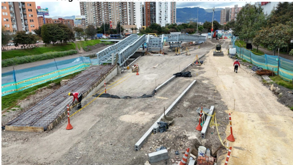
Fotografía N°6: Estado actual costado occidental
