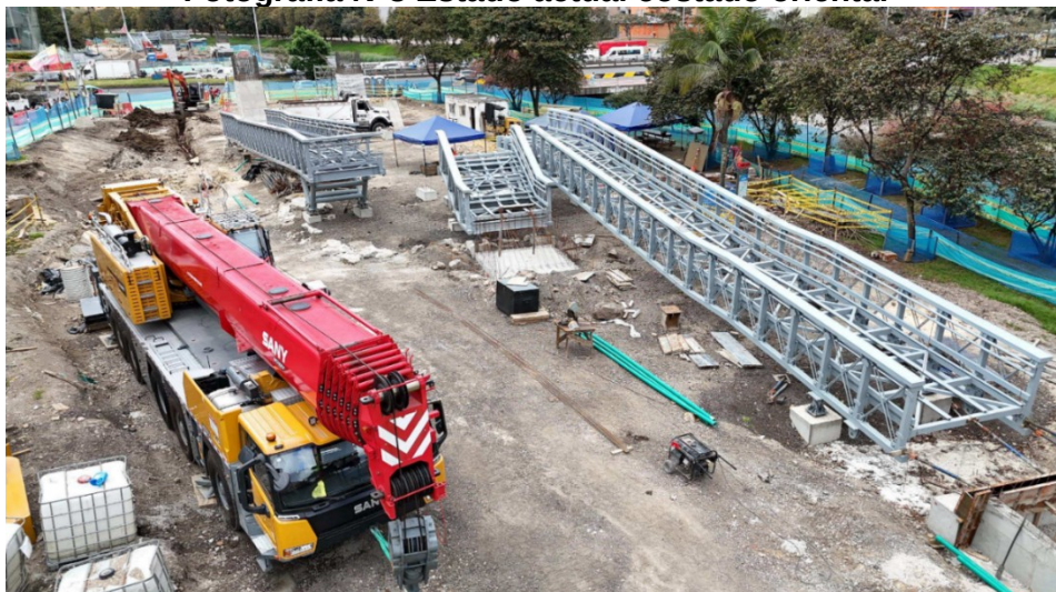
Fotografía N°8 Estado actual costado oriental
