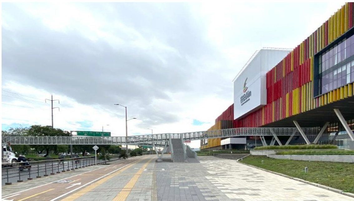
Imagen 1 – Panorámica del Puente. Fuente Construcciones Planificadas
