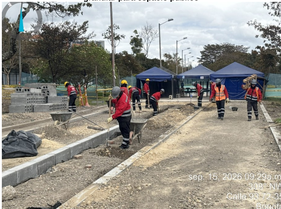
Fotografía N°3: Actividades instalación de bordillo A-80 y conformación de material granular para espacio público
