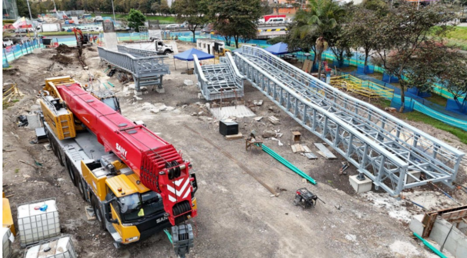
Fotografía N°8 Estado actual costado oriental
