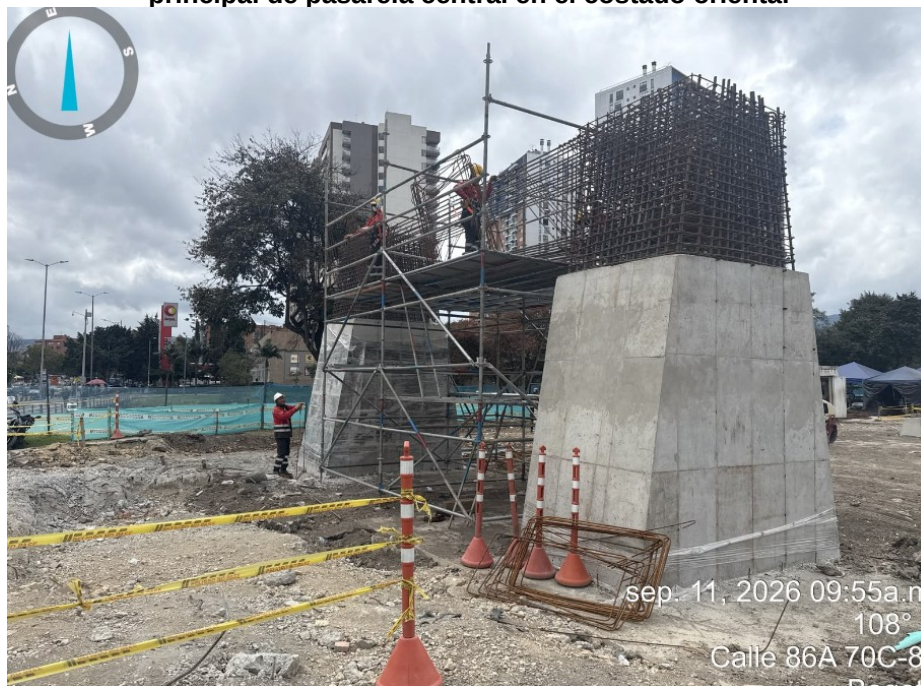
Fotografía N°2 – Armado de parrillas de acero para viga riostra entre Columnas de apoyo principal de pasarela central en el costado oriental
