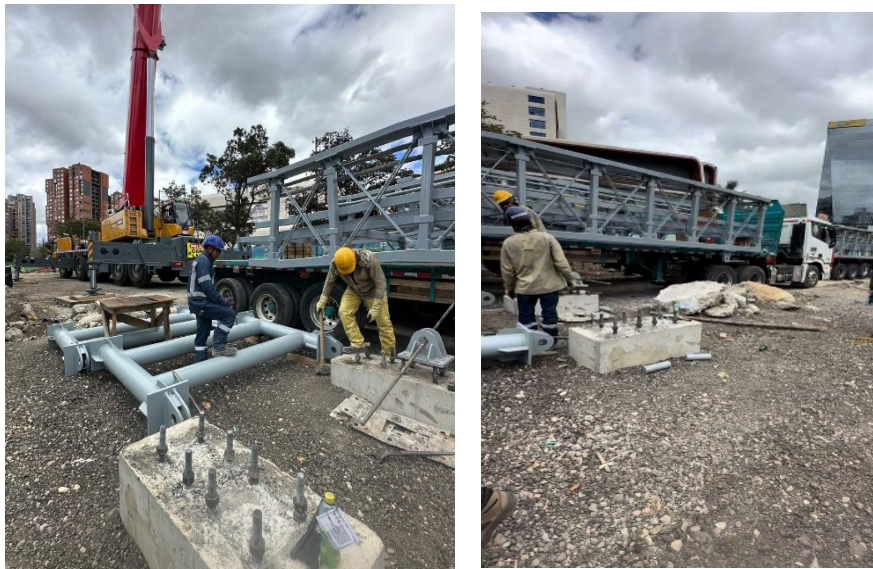
Fotografía N°7: Estructura Metálica en proceso de preensamble y montaje en costado oriental
