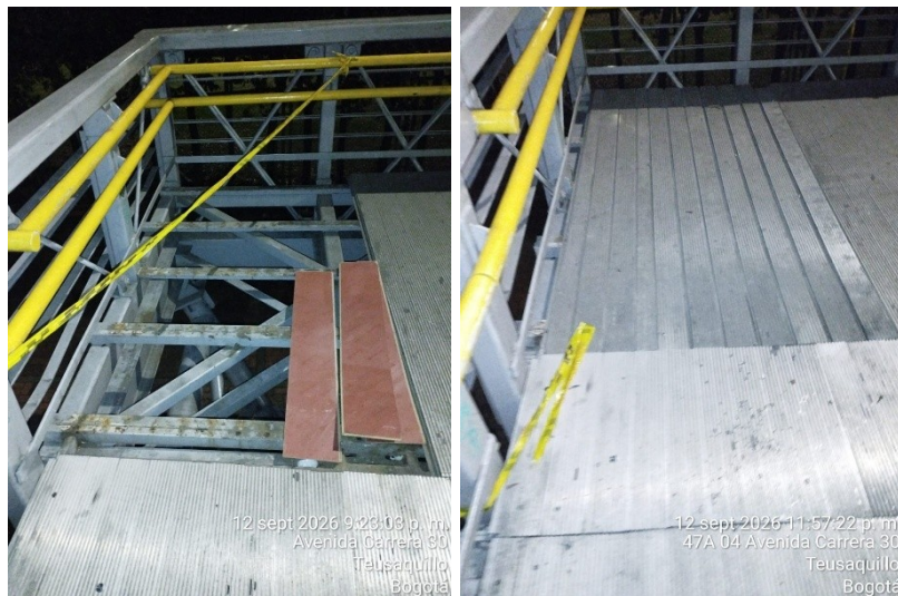
Fotografía No.1 y No.2: Antes y después de la intervención
