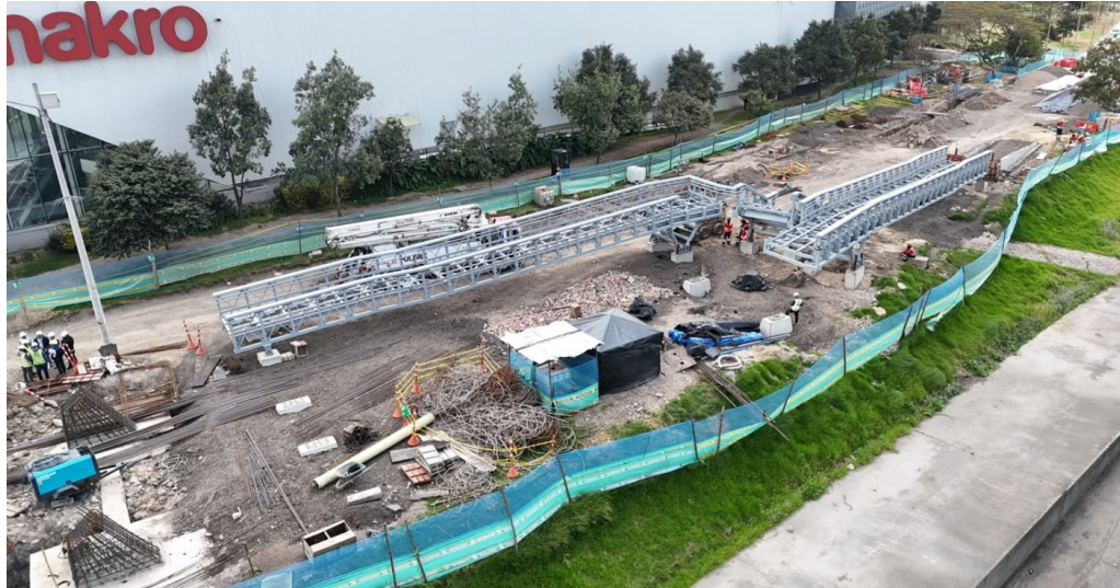
Fotografía N°5: Estructura Metálica en preensamble, en costado oriental
