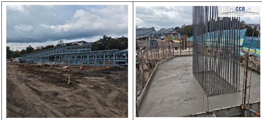
Fotografía N°1: Actividades de obra de cimentación y montaje.
