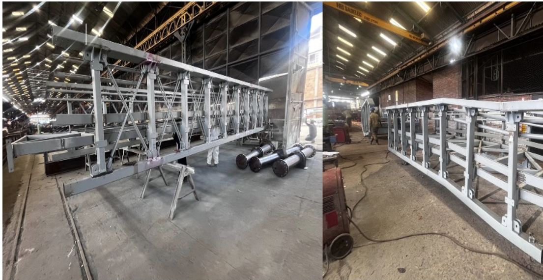
Fotografía N°3: Avance de Estructura Metálica, en visita a planta realizada el 30/07/2026.
