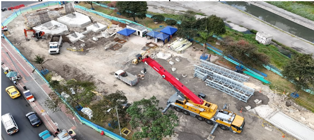
Fotografía N°5: Estructura Metálica en preensamble, en costado oriental
