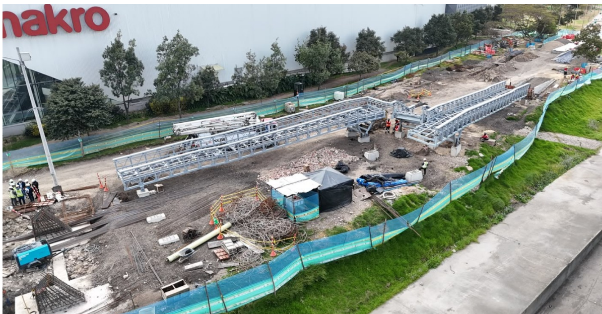
Fotografía N°4: Estructura Metálica izada, en costado occidental
