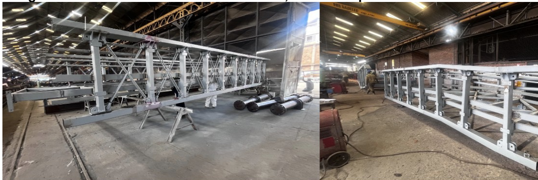
Fotografía N°3: Avance de Estructura Metálica, en visita a planta realizada el 30/07/2026.
